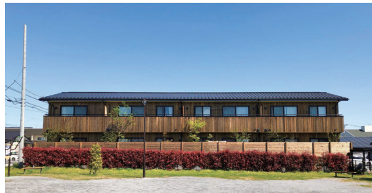
埼玉県産のJAS製材を用いて計画された「弐番町アパートメント」の木造らしい外観
